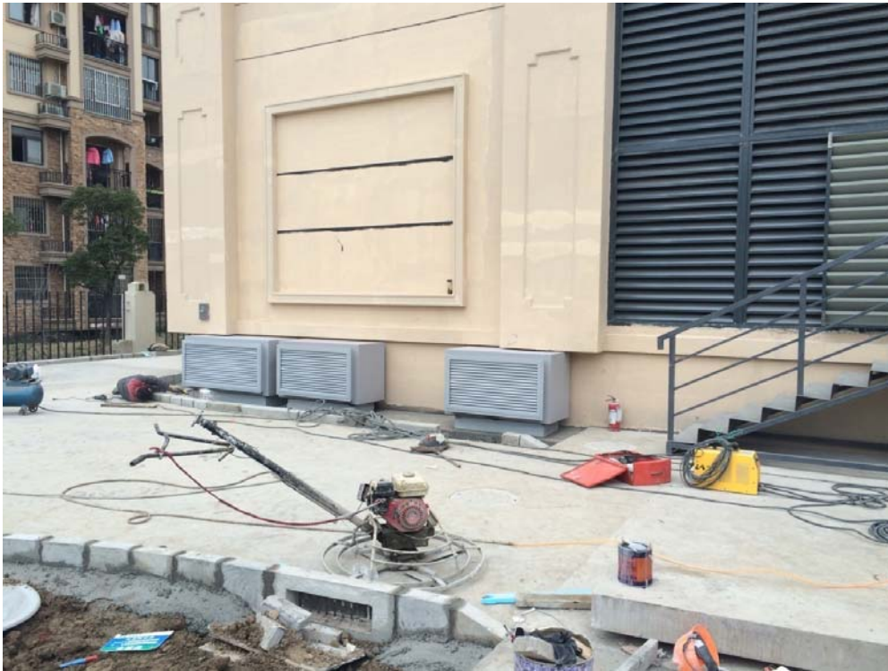
主变室底部进风口消音器组装
