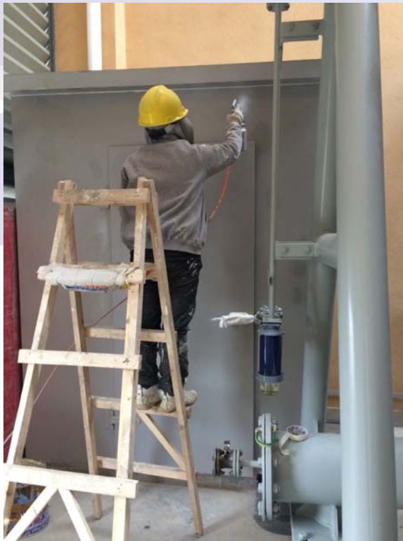
上图：变压器室的定制整体钢制防火声闸
