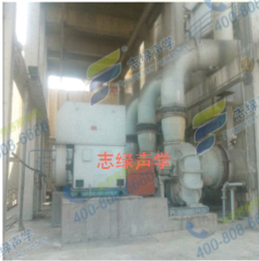
治理 4#塔浆液循环泵现场图片
