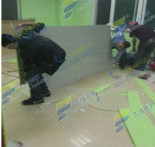
图三：安装纤维吸音板
