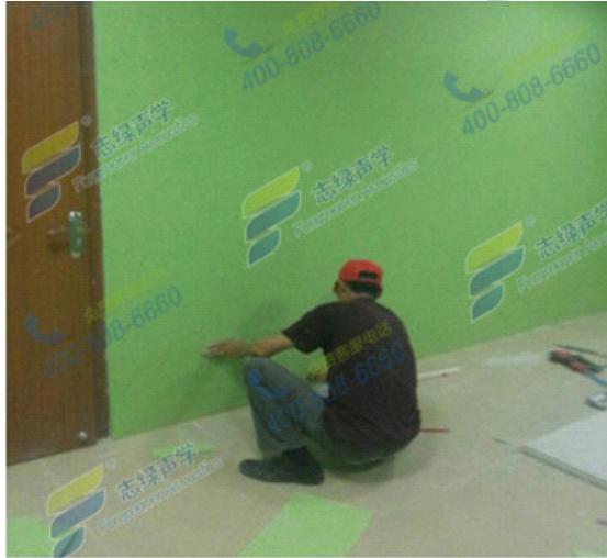
图三：安装纤维吸音板
