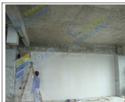
图五：安装隔声板。
