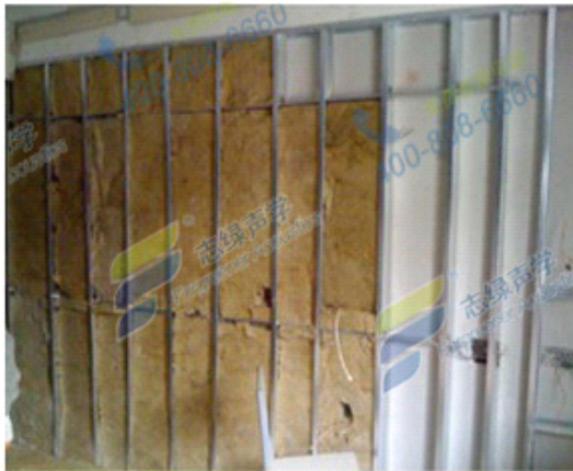
图三：墙体改造施工中
