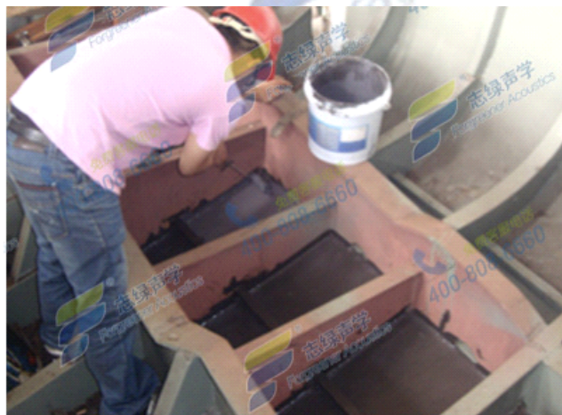
图1：志绿声学工作人员在船首发动机底部钢板涂覆阻尼隔声涂料
