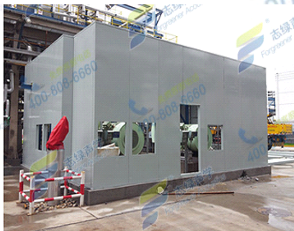
图右：隔声罩的整体安装后效果图（隔声门窗尚未装）
