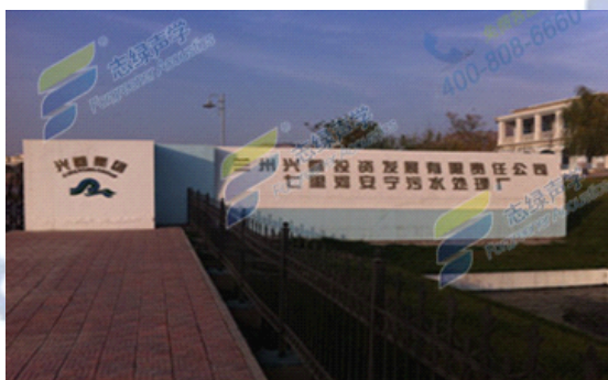
左上图：七里河安宁污水处理厂外景
