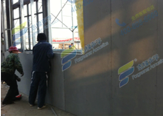
左图：工人正在厂房内表面安装志绿声学超微晶阻尼隔声板
