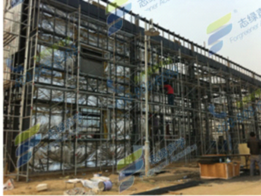
右图：墙体中填充的保温吸音棉
