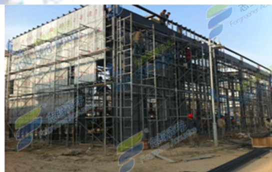
右上图：钢结构鼓风机房（图片中左侧外墙已经部分安装铝塑板，图片中右侧内墙已经部分安装志绿超微晶阻尼隔声板）
