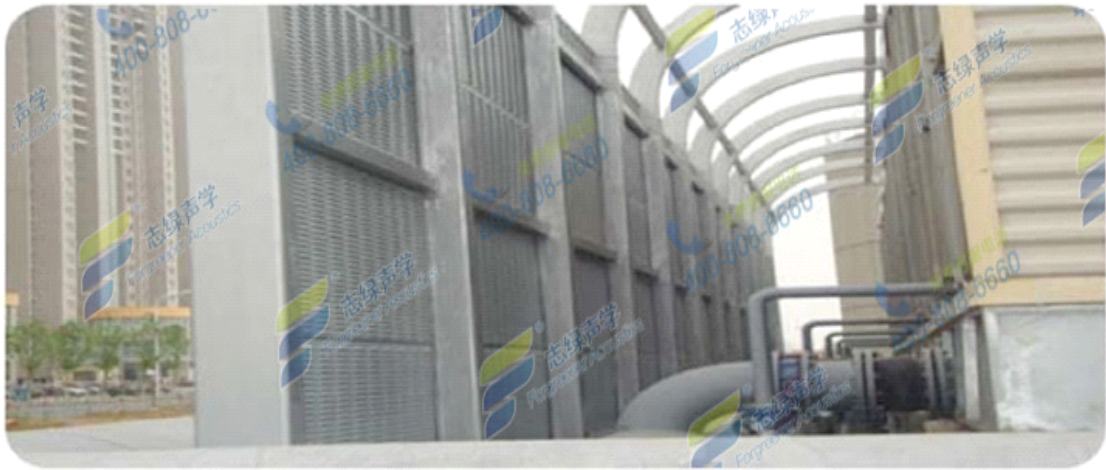
上图：地面声屏障安装后的背面吸声侧照片
