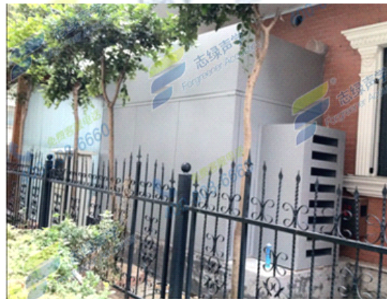
图二：志绿声学设计的模块化通风隔声罩，不仅隔声效果显著，而且可以满足空调的进出风要求。整体外形设计美观，与周围环境协调统一，现场安装仅用半天。
